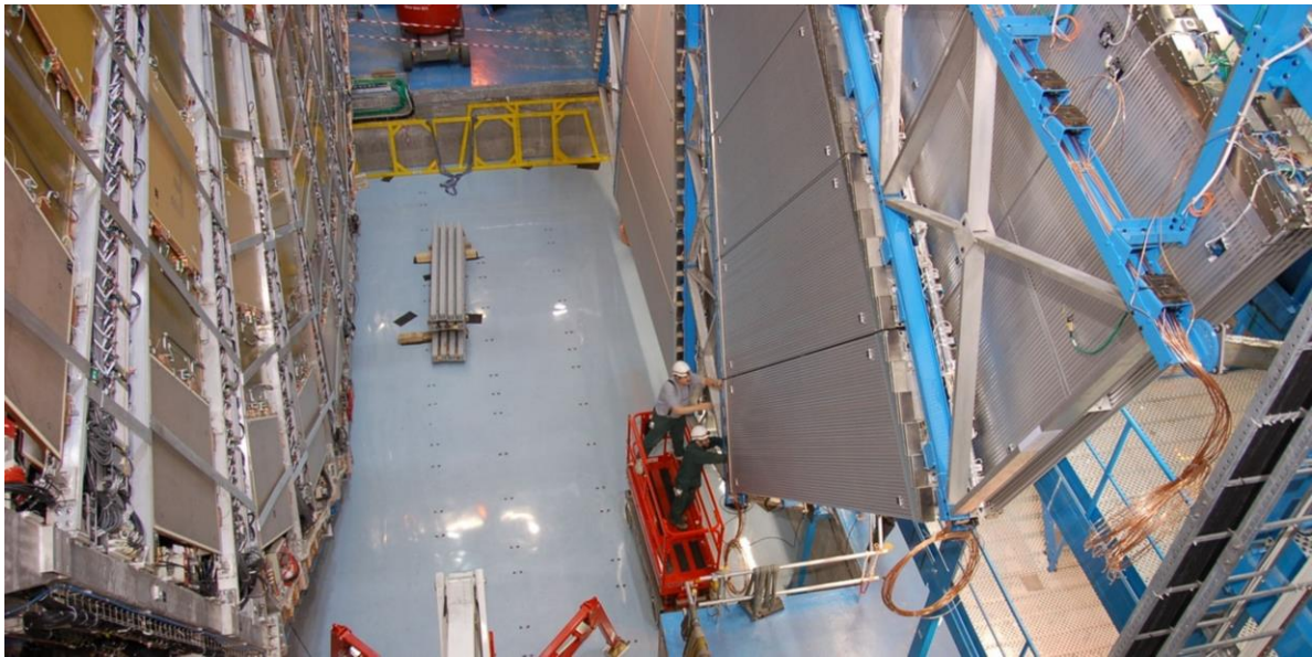
სურ.15-11: კამერების მონტაჟი „ატლას“-დანადგარზე. მარცხნივ - „დიდი ბორბლის“ TGC კამერები, მარჯვნივ - კედლის MDT კამერები (2007 წ.) [15-9].
