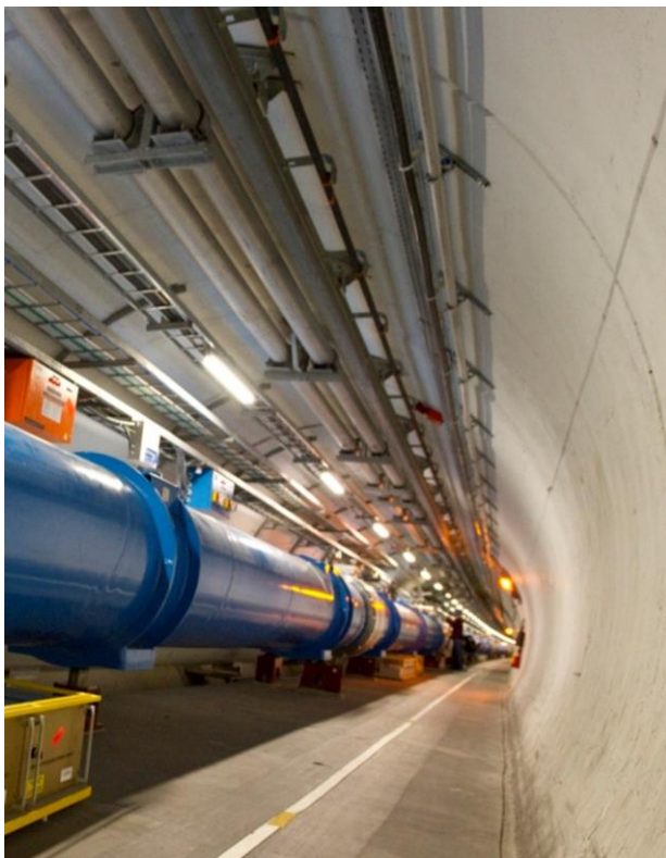
სურ.4-22: დიდი ადრონული კოლაიდერის გვირაბი და ნაწილაკთა არხი
