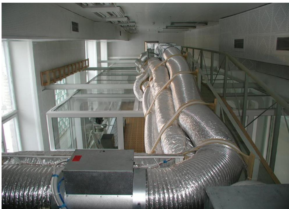
სურ.20-2: ჰაერის ცირკულაციის სისტემების ჰაერგამყვანი მილები და ფილტრები სსო-ს ჰერის ტექნოლოგიურ ტრაპზე
